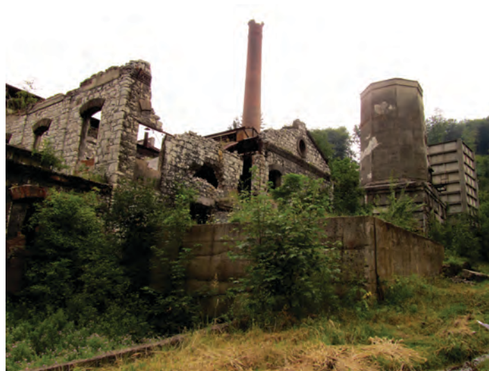
Vedere din curtea Puțului I spre turnul de fum View from the Pit 1 site towards the chimney
