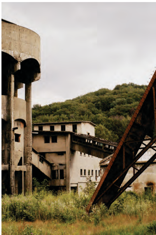
Stânga / Left: Structuri din beton armat în zona puțului I (zona de curățare și sortare a cărbunelui) | The reinforced concrete structures from Pit no. I area
