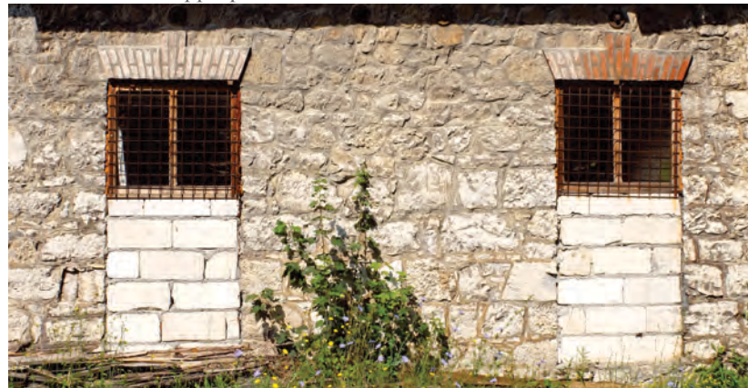
Intervenții neadecvate asupra golurilor de fațadă / Inappropriate interventions on windows/doors
