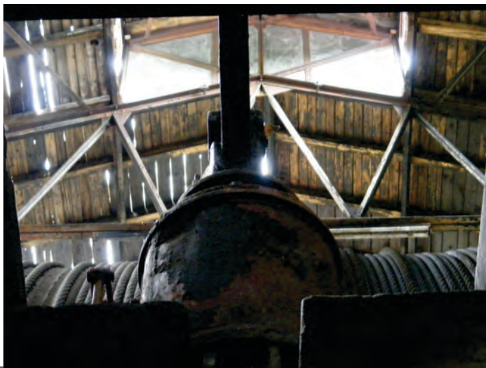
Casa mașinii de extracție The engine house Sursa / Source: Mark Watson
