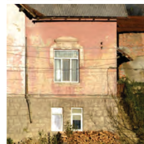
Tămplărie înlocuită Replaced woodwork
