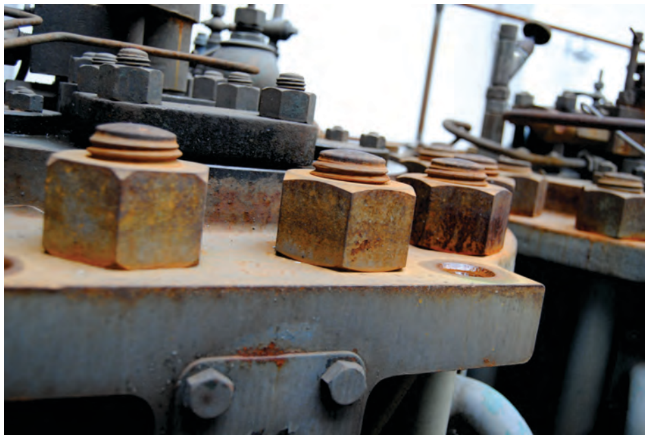
Exemple ale degradării fizice și materiale în Centrala electrică / Examples of material decay of component elements of the Electric Power Station
