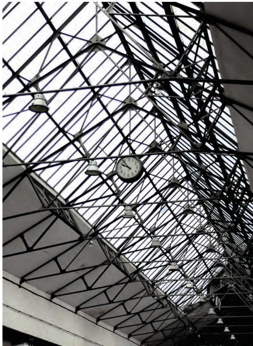
Acoperiș cu structură din ferme metalice / Steel roof frame structure
