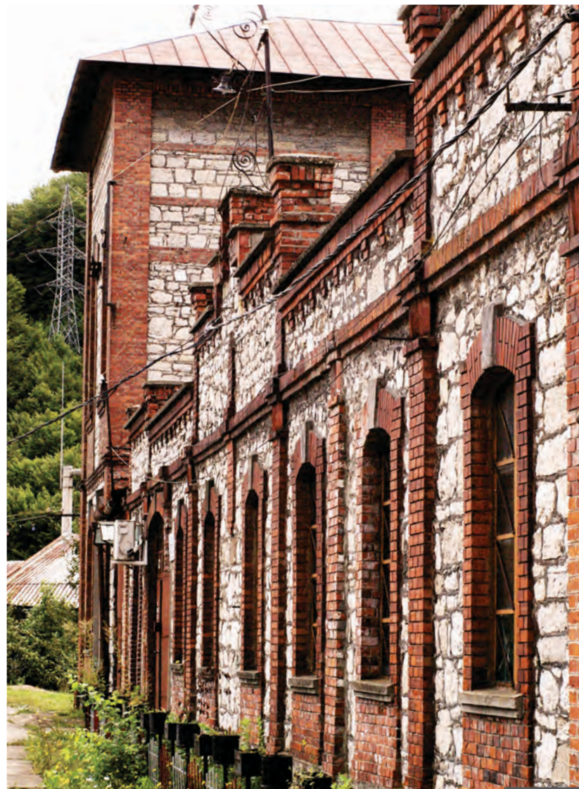
Fațada de nord North façade
